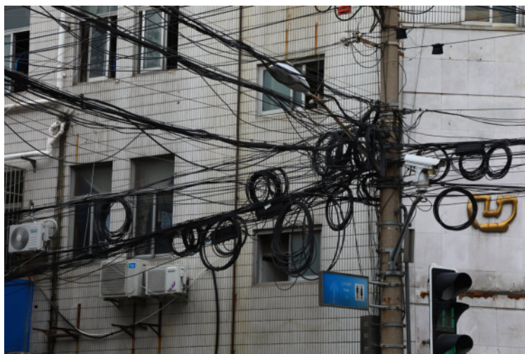
Ich vermute, man hätte diese Kabel übersichtlicher verlegen können.
