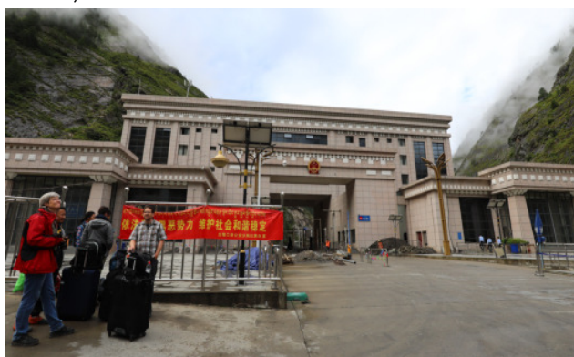
Auf der chinesischen Seite der Grenze stand ein überdimensionales Bauwerk, auf der nepalesischen Seite dagegen nur zwei Wellblech-Hütten.
